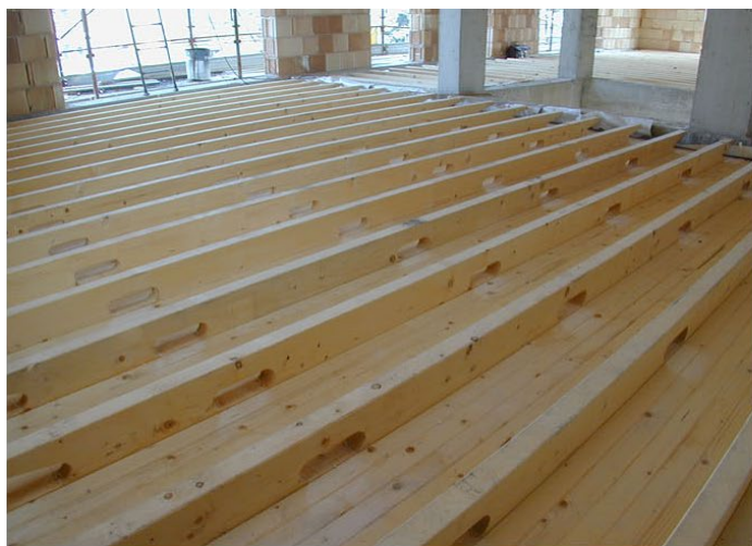
_Sistema costruttivo LegnoLeggo per solai controterra
